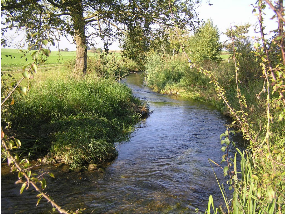
Abb. 3: Die Urtenen zwei Jahre nach Ende der Bauarbeiten
